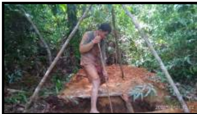
Gambar 2.1 Pembuatan sumur uji ( testpit )
